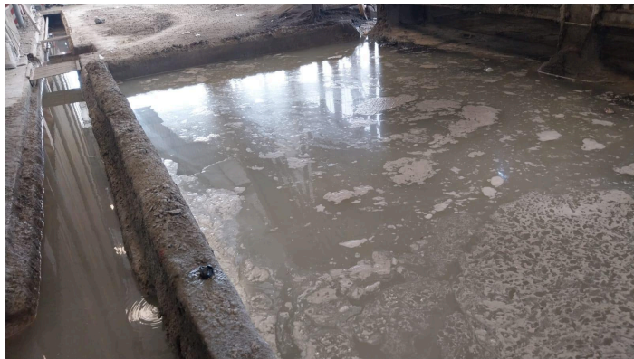
Gambar 1. Kolam Penampungan Air
