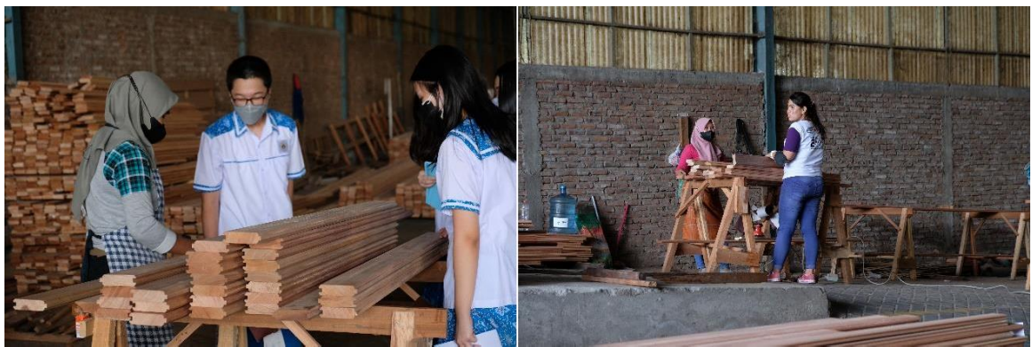
Gambar 6.14 Balok Kayu yang Diampelas
