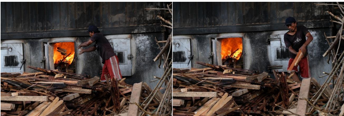
Gambar 6.11 Memasukkan Kayu Pada Mesin Boiler
